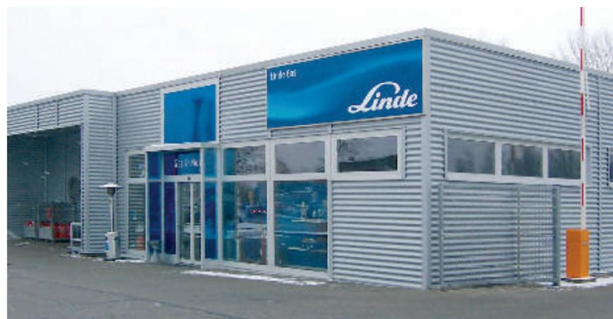
Die TECNO wird mit stützenfreien Breiten bis zu 30,00 m und Innenhöhen bis zu 6,10 m geliefert. D.h., die Konstruktion der Halle erlaubt großzügige Ausstellungsflächen ohne störende Stützen auch für hoch aufragende Produkte. Die Halle ist durchgehend mit Sandwichpaneelen ausgekleidet und verfügt deshalb über beste Dämmwerte.
